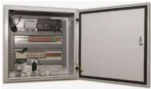
Станции телемеханики кустовые типа СТК-ZISI (далее — СТК-ZISI) предназначены для измерения унифицированных аналоговых токовых сигналов, поступающих на ее входы от первичных измерительных преобразователей напряжения, тока, температуры, давления и пр., оперативного сбора, обработки, архивирования и передачи измерительной информации на диспетчерский компьютер, формирование и выдачу управляющих сигналов.
