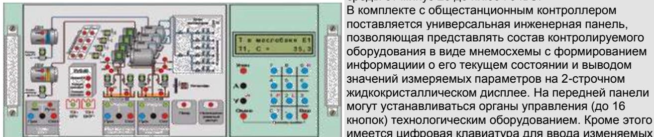
В комплекте с общестанционным контроллером поставляется универсальная инженерная панель, позволяющая представлять состав контролируемого оборудования в виде мнемосхемы с формированием информации о его текущем состоянии и выводом значений измеряемых параметров на 2-строчном жидкокристаллическом дисплее. На передней панели могут устанавливаться органы управления (до 16 кнопок) технологическим оборудованием. Кроме этого имеется цифровая клавиатура для ввода изменяемых
