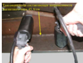
Контроль угловых соединений, галтелей
